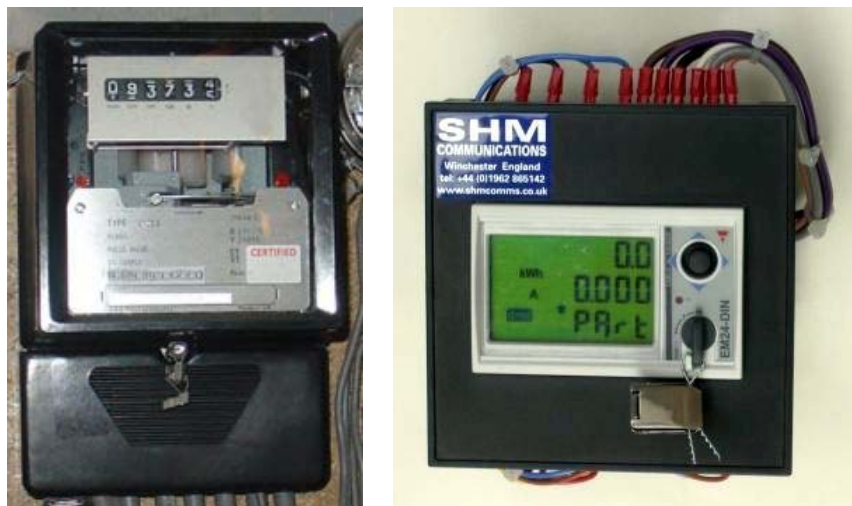
Gambar 2.15 Kwh meter tiga fasa analog dan digital
