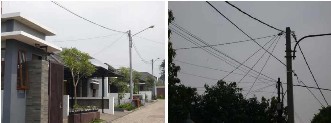
Gambar 2.6 Saluran penghantar udara untuk bangunan-bangunan kecil (mengganggu keindahan pandangan)
